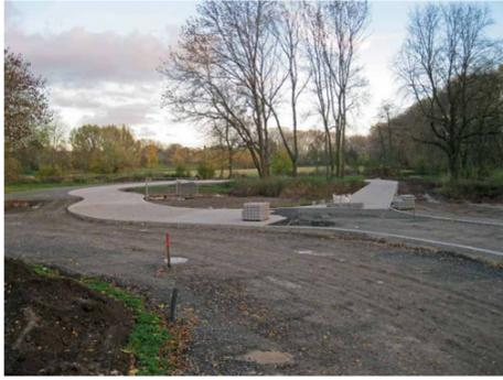
oben: Der Wohnmobilpark Okerawe erhält seinen Erschließungsweg. Beidseitig des Weges werden 6x8m Schotterrassen-Stellplätze gebaut. Für über 40 Wohnmobile wird hier eine herrliche Lage direkt am Okerufer geboten. Eine eigene Sanitäranlage, eigene Stromanschlüsse und eine zentrale Entsorgungsstation runden das Angebot ab. Auch ein Kanuanleger steht zur Nutzung zur Verfügung.
