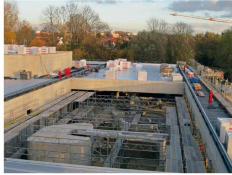
oben: Hier können Sie einen Blick durch die Dachöffnung werfen, die später per verfahrbarem Dach das Freibadfeeling im Allwetterbad ermöglicht. Das Dach ist so groß, dass es schon bei moderaten Wetterbedingungen fast den gesamten Freizeitbereich freistellen kann. Dieser Freibad-Effekt wird durch die großzügigen Fassadenfensterelemente noch verstärkt, die zur Südseite hin geöffnet werden können.
