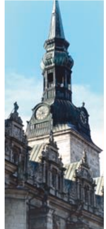
Kirchturm und Nordfassade der Hauptkirche BMV.
