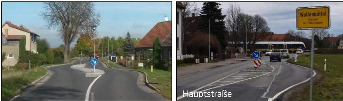
**Abb. 28** Beispiele Ortseingangsgestaltung – Mittelinsel mit Fahrstreifenversatz
