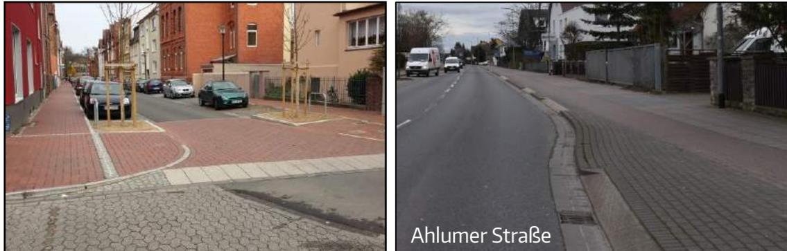
**Abb. 27** Beispiele zur Abgrenzung des Nebennetzes mittels Gehwegüberfahrten
