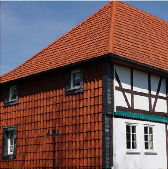
Abb. 4 Mit Hohlfalzziegeln eingedektes Walmdach
