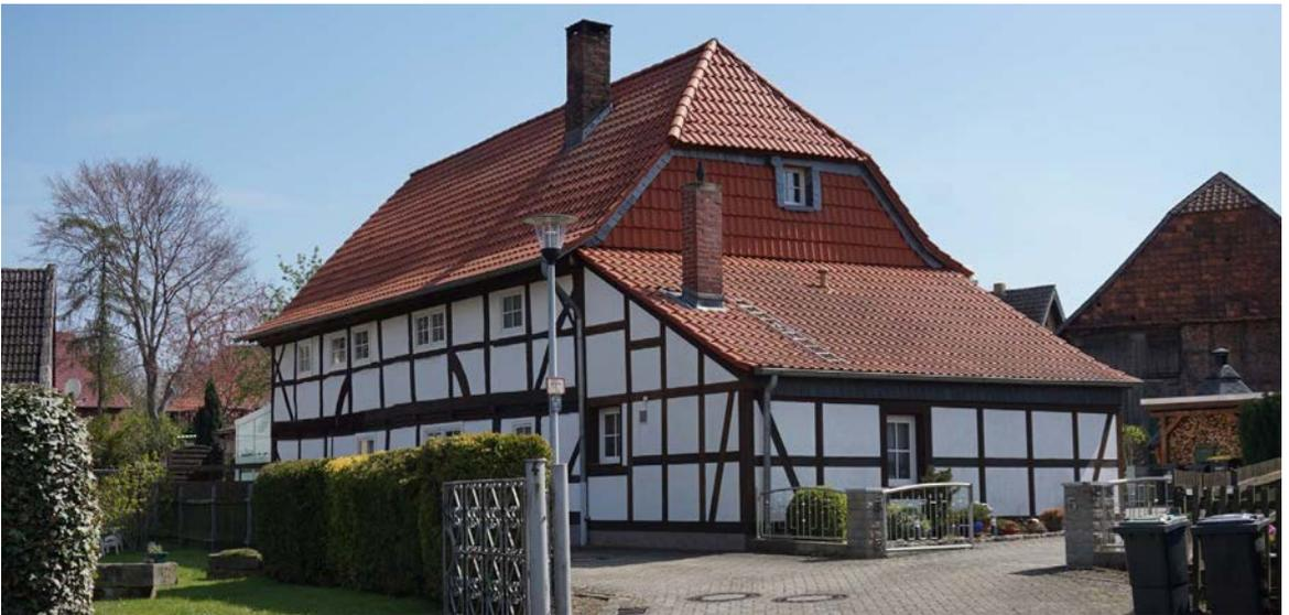
Abb. 3 Gebäude mit Krüppelwalm und mit Tonziegeln abgehängtem Giebel
