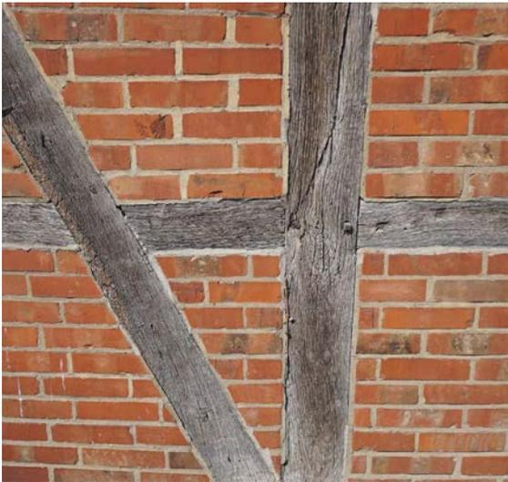
Abb. 9 Mit Ziegeln ausgemauertes Fachwerk
