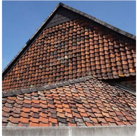
Abb. 5 Die typische Abhängung des Giebeldreiecks eines Satteldaches mit Linkskrempern
