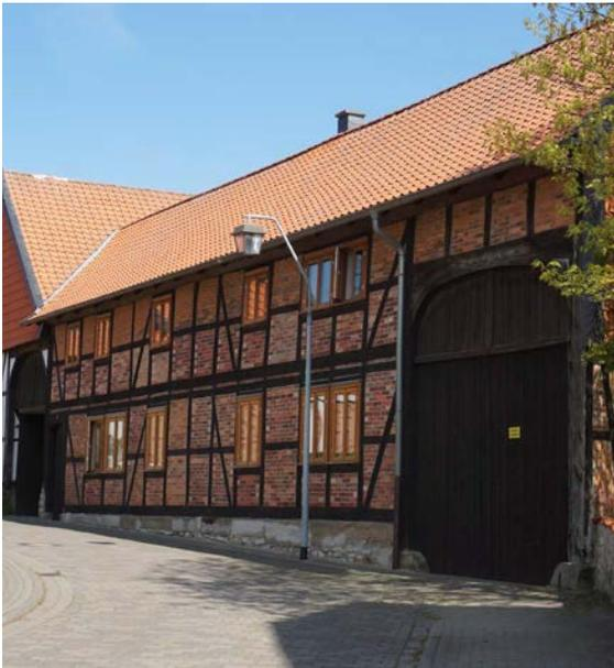
Abb. 9 Mit Ziegeln ausgemauertes Fachwerk
