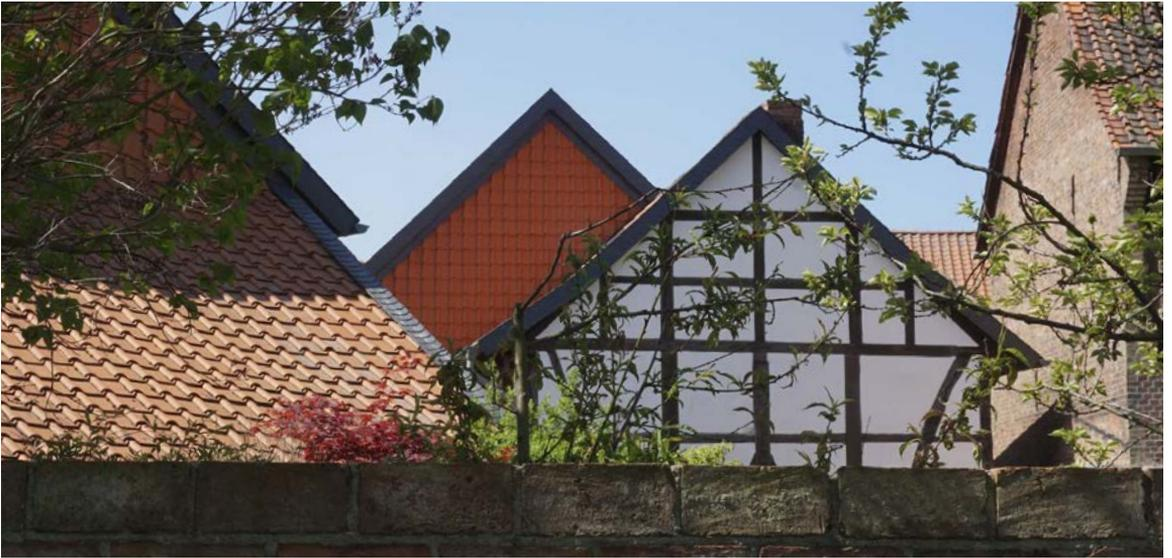
Abb. 3 Gebäude mit Satteldächern – im Vordergrund ein Fachwerkgiebel, im Hintergrund ein mit Tonziegeln verkleideter Giebel, rechts ein gemauerter Giebel
