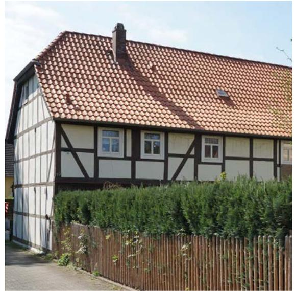
Abb. 5 Mit Hohlfalzziegeln eingedecktes Krüppelwalmdach
