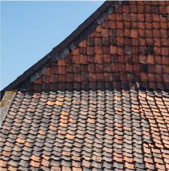
Abb. 4 Die typische Abhängung des Giebeldreiecks eines Satteldaches mit Linkskrempern
